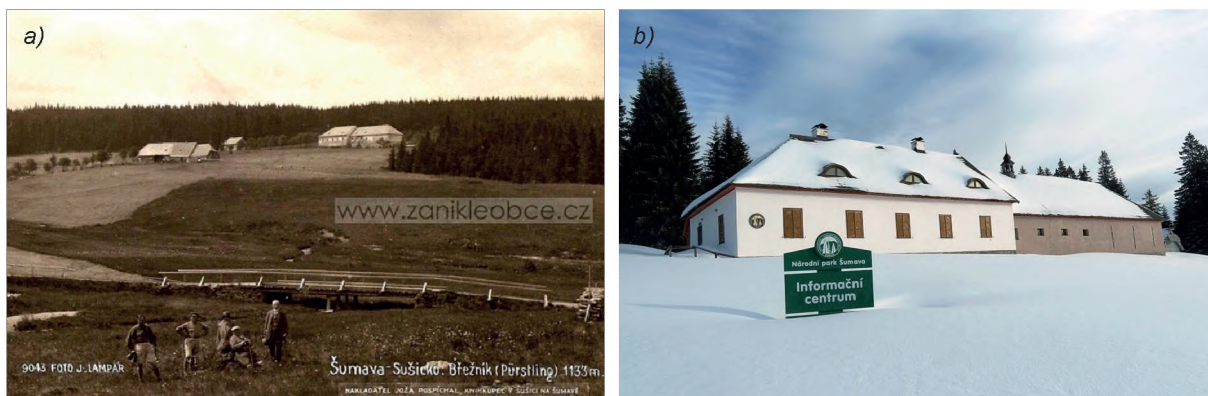
Obr. 1 Březník a) na dobové fotografii z roku 1928 (zdroj: zanikleobce.cz) a b) s rekonstruovanou hájenkou se zvonicí v únoru 2019. Foto: autor příspěvku.
