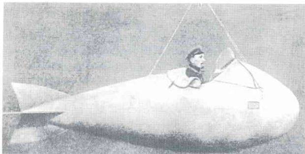
Obr. 6 Pozorovatelská neboli špehovací gondola ve tvaru bomby, zavěšená na laně, která se spouštěla ze vzducholodí pod oblačnost. Stabilizační plochy tlumily její rozkvyv během letu. Podle [8].
