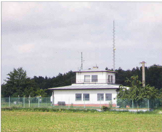
Obr. 1 Typické efekty ovlivňující naměřené rychlosti větru na profesionální meteorologické stanici (Kuchařovice). Umístění anemometru nad střechou domu vede k nadhodnocení naměřených rychlostí větru, naměřené větrné podmínky jsou dále mírně ovlivněny lesním porostem v pozadí (tento potenciálně značný vliv je zde limitován nízkou četností proudění ve směru od lesa), blízkými stromy, měřicím stožárem a sousedním anemometrem. Při použití naměřených dat je nutno mít tyto vlivy na vědomí.
