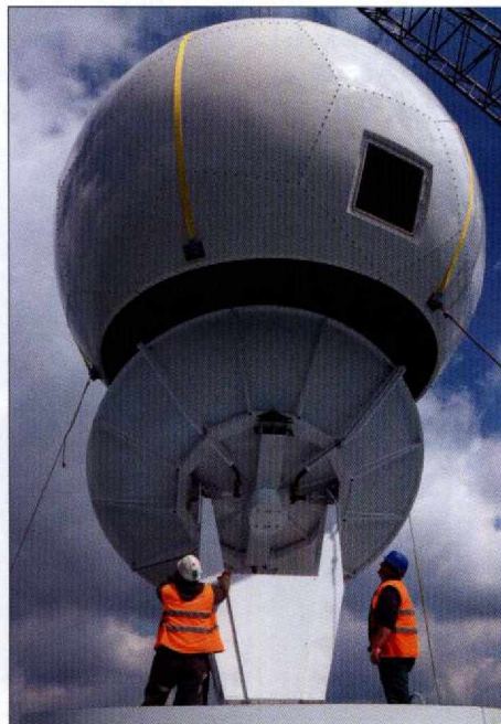
Obr. 1 Instalace nové kopule antény na radarovou věž radaru Brdy.
