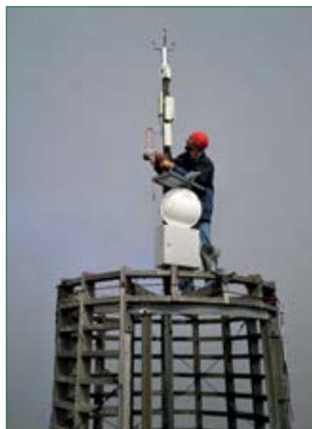
Obr. 5 Instalace nového anemometru WMT700, říjen 2011. Foto Vladimír Vozobule.
