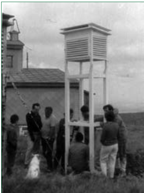
Obr. 3 Instalace vyvýšené meteorologické budky na Lysé hoře. Foto N. Slabá.
